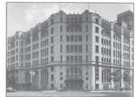
旧肥後橋本社ビル (設計:W・M・ウォーリス)
